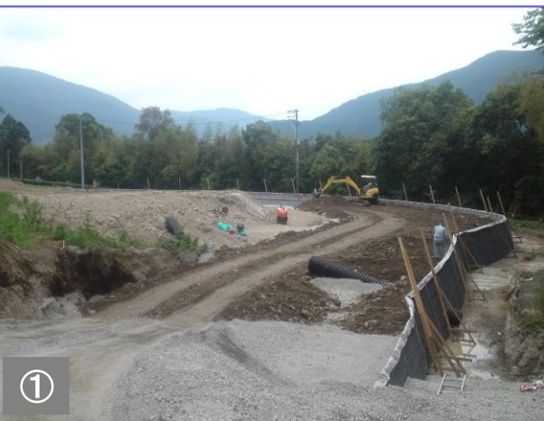
盛土工が本格的に始まりました。
