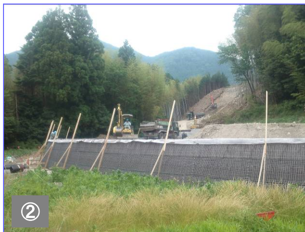
補強土壁、前面の様子です。
