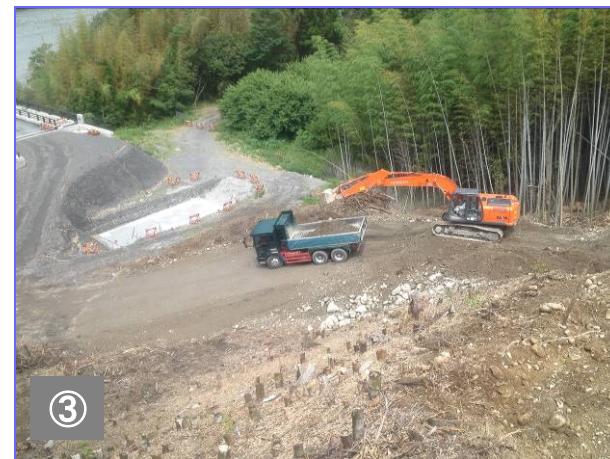
青部バイパスの掘削した土砂を盛土工に使うための土砂を搬出しています。
